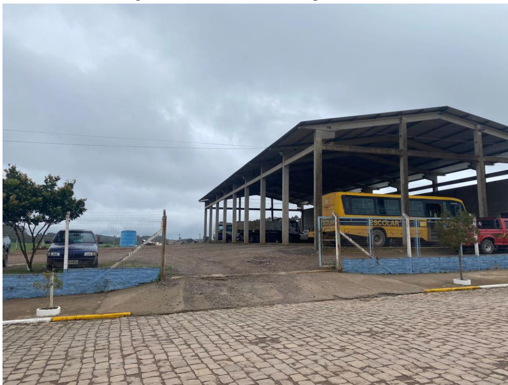
Figura 35 - Secretaria Municipal de Obras
