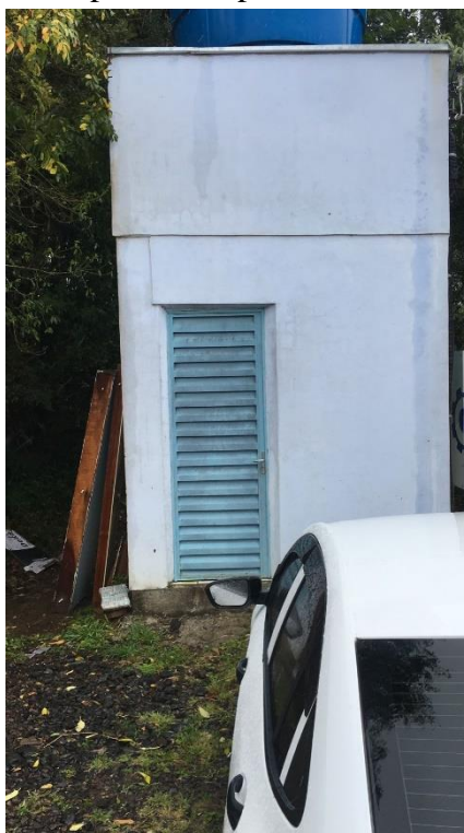
Figura 112 - Depósito temporário de resíduos
