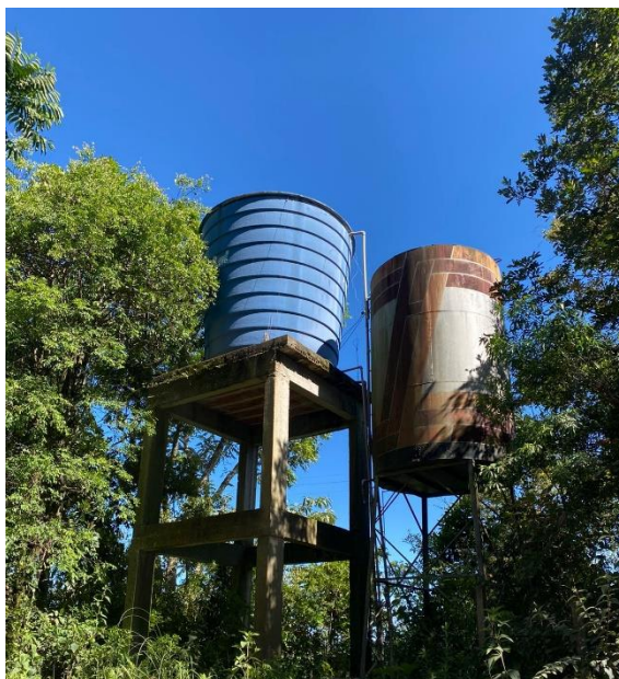
Figura 79 - Reservatório de água localizado na Linha Faber
