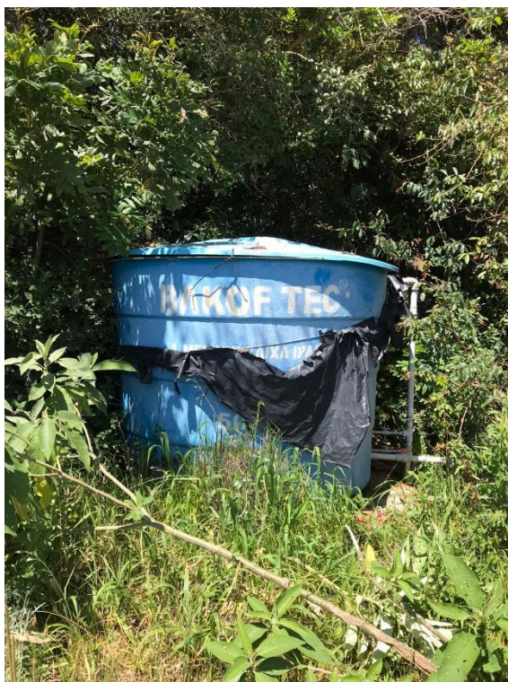
Figura 95 - Reservatório de água da Linha Francesquet
