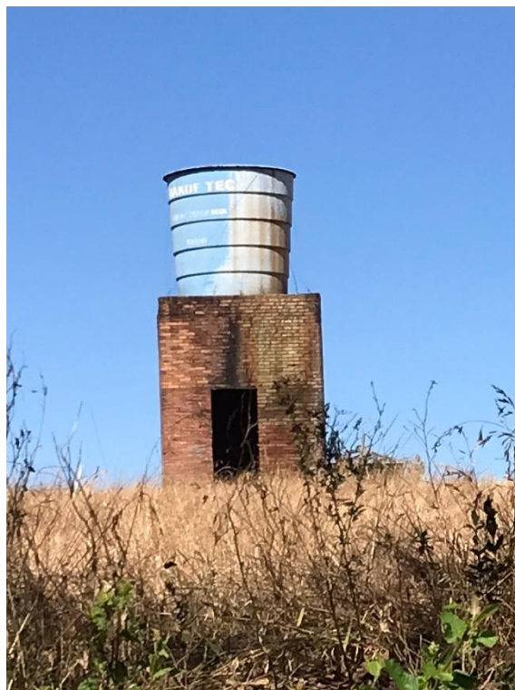
Figura 84 - Reservatório de água da Linha Altas Fundos
